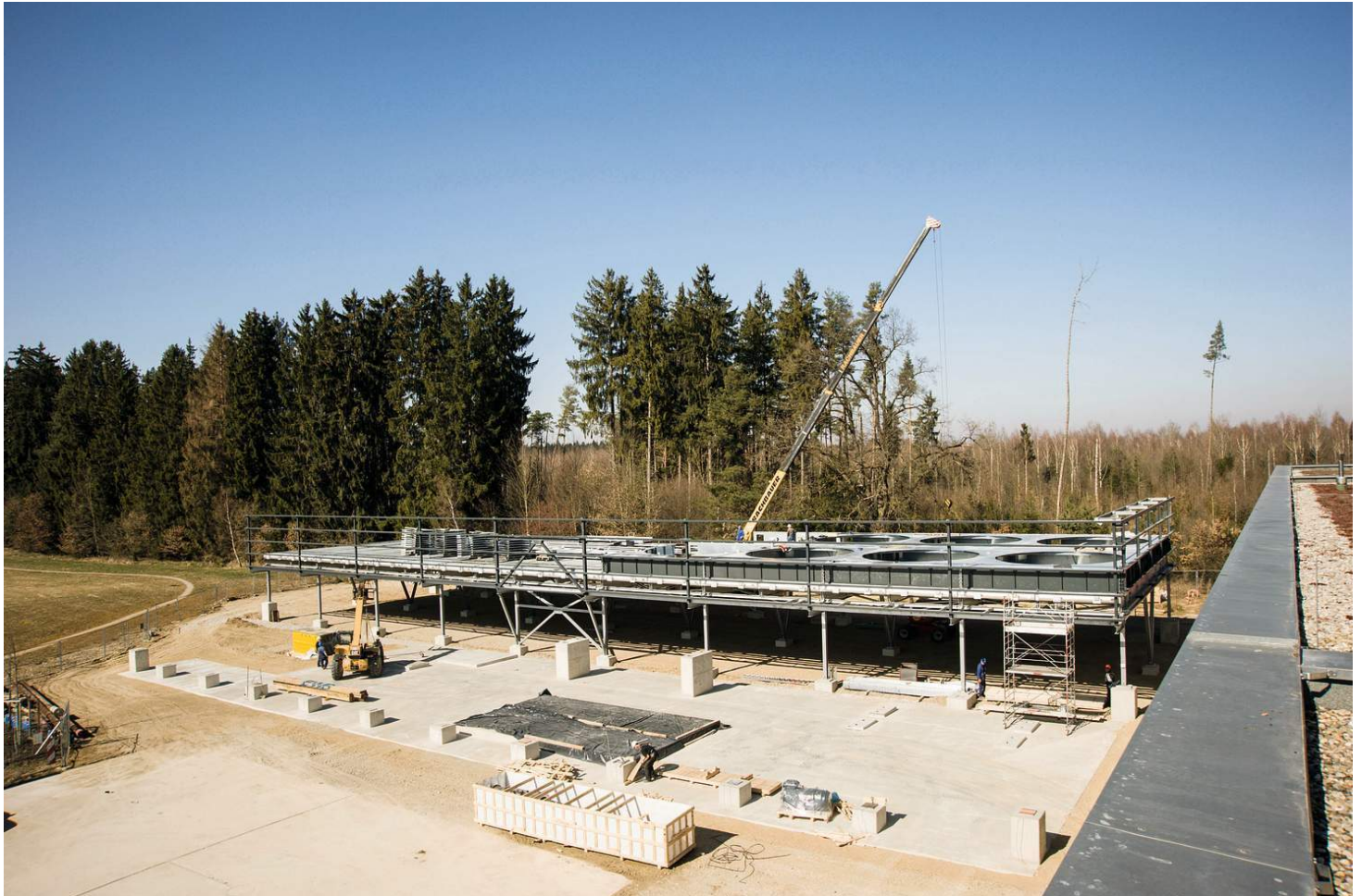
Bild: Erdwärme Grünwald Strom und Wärme als Konzept: In Laufzorn entsteht derzeit ein Geothermiekraftwerk, das die ORC-Technologie nutzt (Bild). Die Stadtwerke München haben Anfang des Jahres in Sauerlach ihr Geothermiekraftwerk mit 5MWel und einer maximalen Wärmeauskopplung von 4MW in Betrieb genommen.
